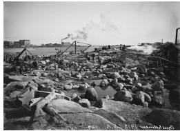
A3 Satamanrakennustöitä Jätkäsaarella - Signe Brander 1913
