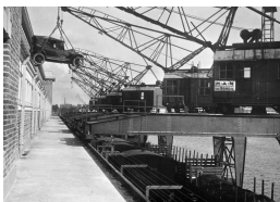
A15 Purkutöitä Jätkäsaaren laiturin varaston L3 kohdalla - K.O. Broström 1920-1929
