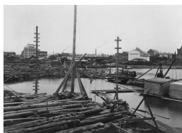
A11 Satamanrakennustöitä Jätkäsaarella - Erik Sundström 1913
