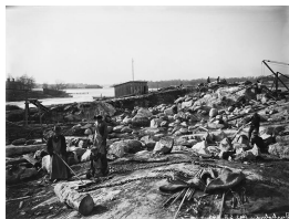
A7 (saunatilat) Satamanrakennustöitä Jätkäsaarella - Signe Brander 1913
